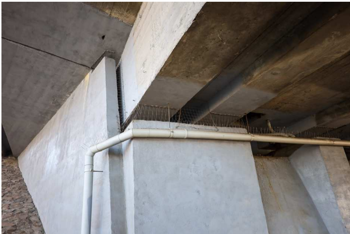
Fot. 8. Zabezpieczenia przed gołębiami pokrywały praktyczne cale filary wzdłuż ciągów pieszych.
