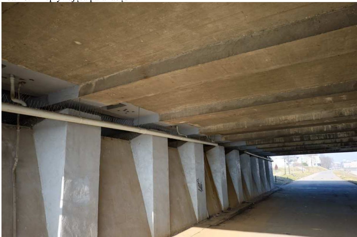
Fot. 19. Obie strony mostu zabezpieczone przy filarach na przyczółkach przed przesiadywaniem i gniazdowaniem gołębi.
